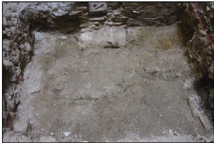
UE-09 un cop desmuntada la part afectada dels murs UE-05 i 06
